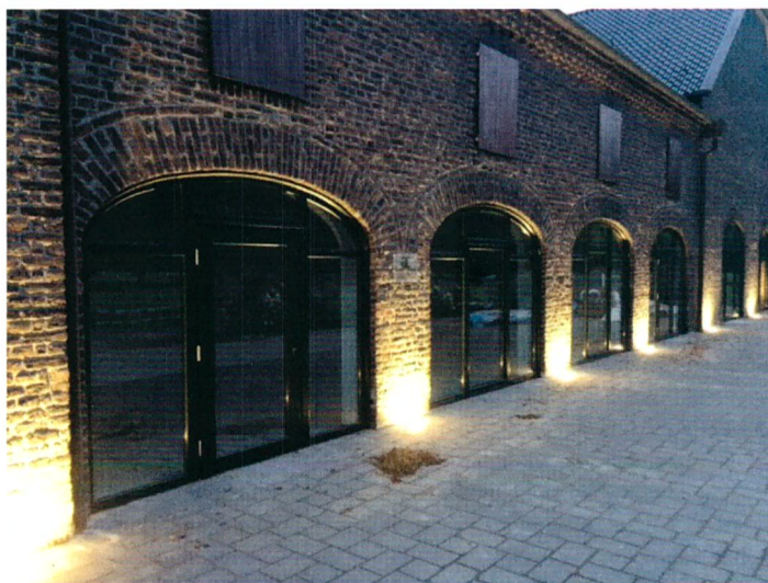
Der Denkmalschutz verbietet eine Beleuchtung am Gemäuer, deshalb sorgen Bodenstrahler für eine reizvolle Atmosphäre.
